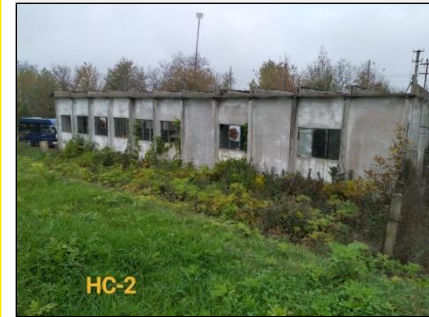
Будівля ЗРУ НС-1
